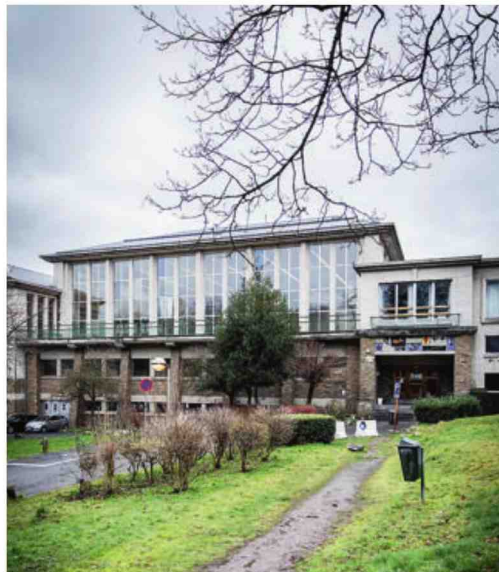
La piscine communale verviétoise sera bientôt dotée de technologies énergétiques innovantes. © TONNEAU
